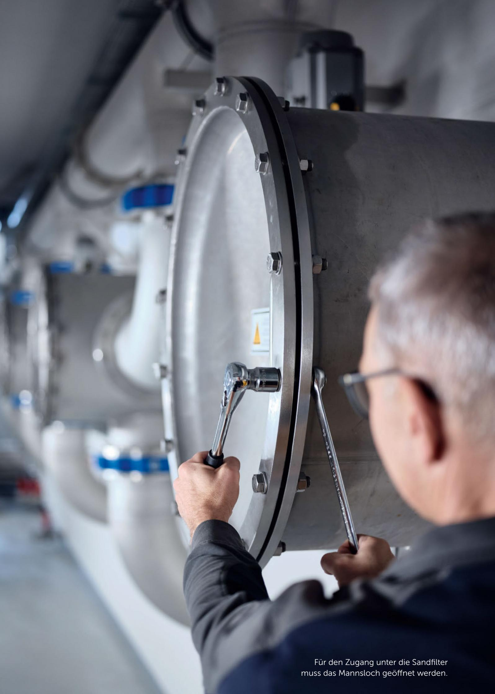
Für den Zugang unter die Sandfilter muss das Mannsloch geöffnet werden.
